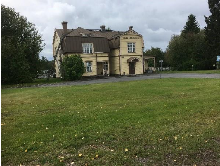
Kuva 7. Mahdollisena päiväpiilona tarkasteltu Villa Lipporanta. Lepakoita ei havaittu.
