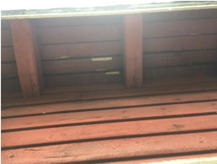
Kuva 6. Mahdollinen sisäänpääsy Villa Pukkilan varistorakennukseen.
